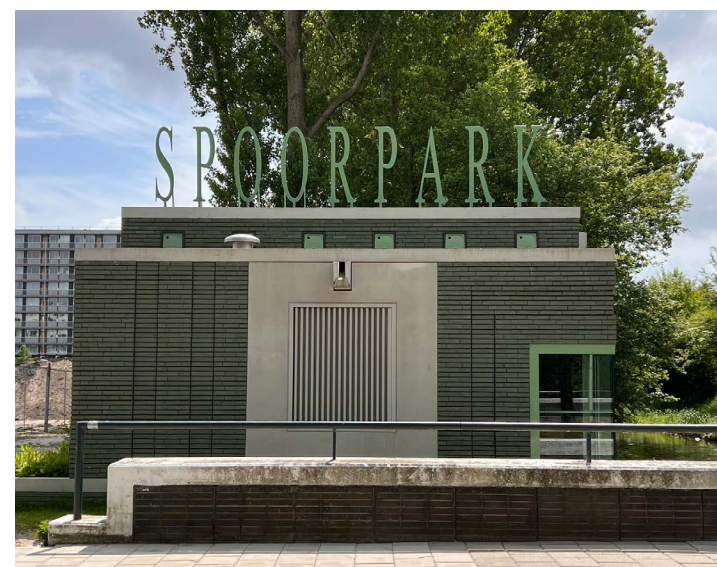
2. Nieuw rioolgemaal, Postjesweg 529, opgeleverd in 2023. Het rioolgemaal pompt het afvalwater uit de buurt naar de rioolwaterzuivering Amsterdam West. Het is ontworpen met natuurinclusieve maatregelen.
